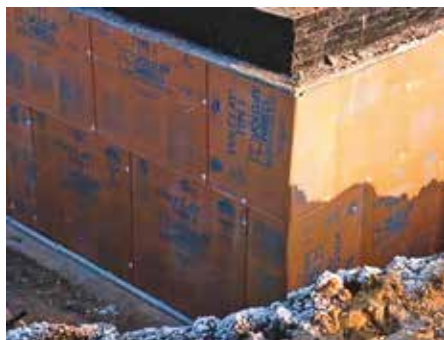
Kellerwandabdichtung mit Bentonit-Panels (Foto: CRP Bauingenieure)
