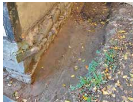
Kellerwandabdichtung mit DERNOTON
