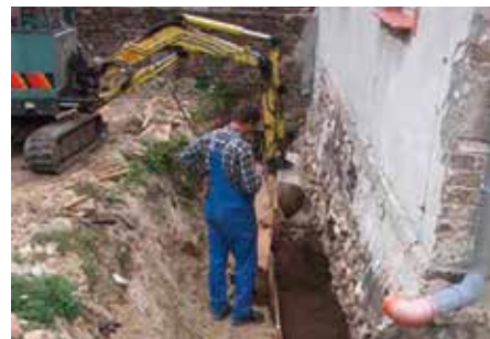
Einbau einer DERNOTON Abdichtungsschicht (Fotos: DERNOTON)
