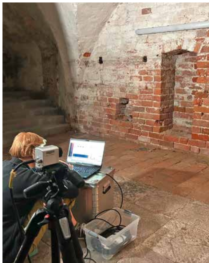
Bauzustandserfassung mit zerstörungsfreien Methoden in einem mittelalterlichen Keller. (Fotos: Barbara Beckett)
